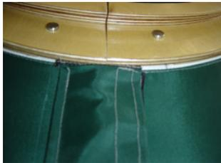
Übergelegte Klettklappe über den zugezogenen Reißverschluss. Sichtbar auch der Abschluss am Waschbord
